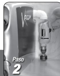
Preensamble las partes para comprobar si encajan con el escudete (con la etiqueta en el agujero) y el alambre instalado (el escudete tiene una ranura para pasar el alambre a lo largo del tubo). Retire el preensamble, pegue con cola el montaje y conéctelo a la línea central. No pegue con cola la línea de vacío al accesorio de la unidad Vroom. Conecte los alambres de baja tensión desde el aparato Vroom a los alambres de baja tensión procedentes de la línea central usando tuercas para alambres.
